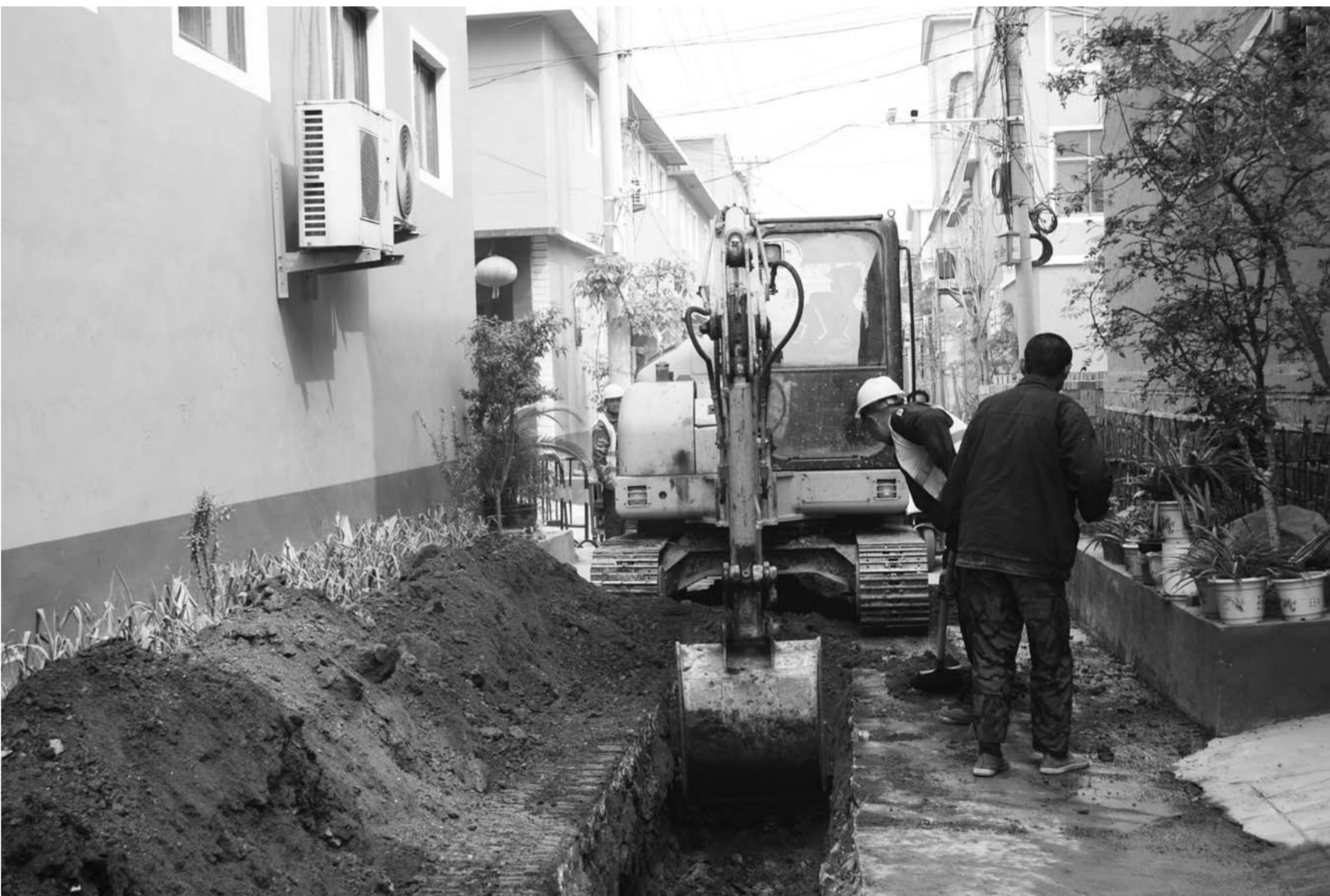
近日，荷花路街道各村污水管道正在铺设施工。据了解，该街道今年农村污水治理工程施工计划共涉及12个村，5000余户农户。（荷花路街道）
